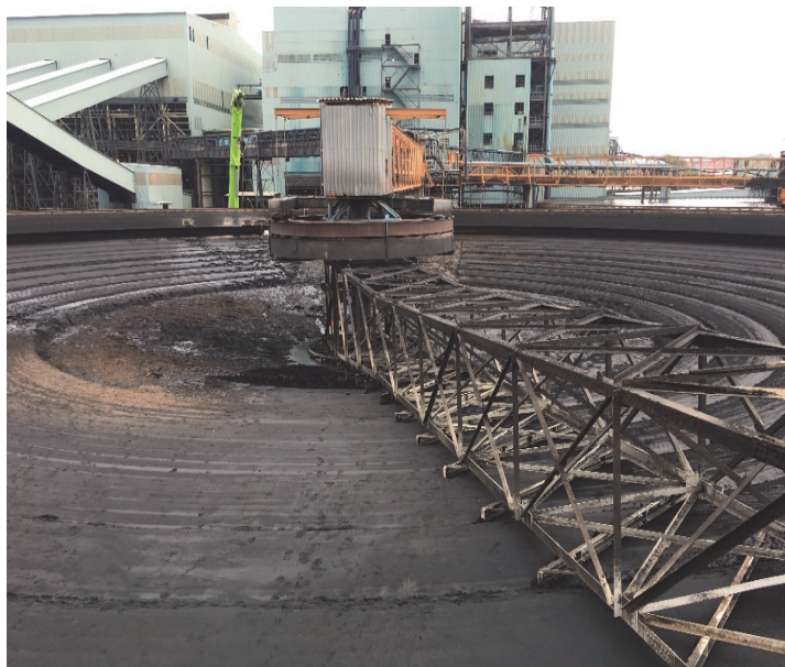
Рис. 10. Фрагмент гравитационного сгустителя 70 м до удаления осадков мелких фракций (предоставлено Concrete Canvas Ltd, 2016)
