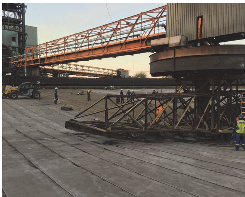
Рис. 13. Монтаж бетонного полотна «ССН8» завершен (предоставлено Concrete Canvas Ltd, 2016)
