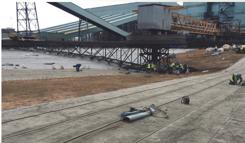
Рис. 11. Разворачивание бетонного полотна «ССН8» (предоставлено Concrete Canvas Ltd, 2016)
