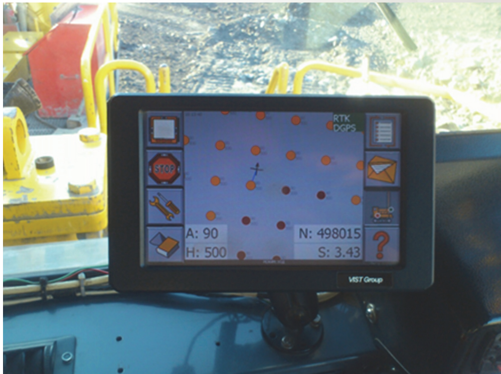
Рис. 3. Фотография оборудования, установленного в кабине бурового станка
